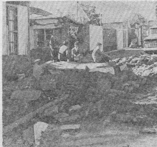
ASPECTO DE una calle en el pueblo de Salamanca, provincia de Coquimbo, después del terremoto del 8 de julio.
